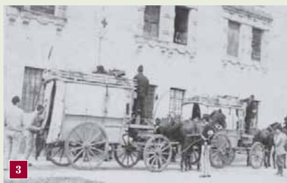
2 Raro esemplare del carro a trazione animale, rivestito all'interno di refrattari (20 q.li circa), per la cottura al campo delle pagnotte destinate all' alimentazione dell'esercito (collez. Mozzo)
